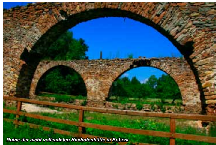
Ruine der nicht vollendeten Hochofenhütte in Bobrza
