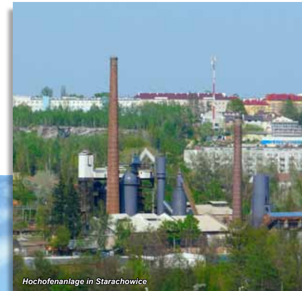
Hochofenanlage in Starachowice
